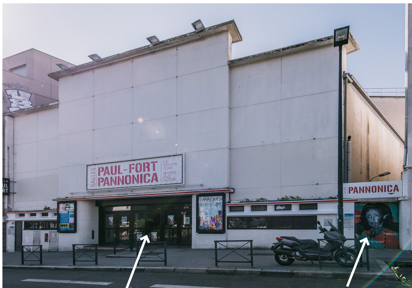
Entrée salle Paul Fort et billetterie Salle entièrement accessible.
